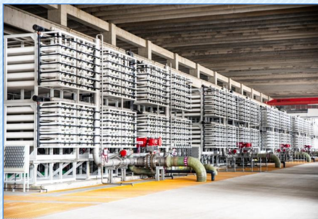
天津南港工业区先达海水淡化及综合利用一体化项目
